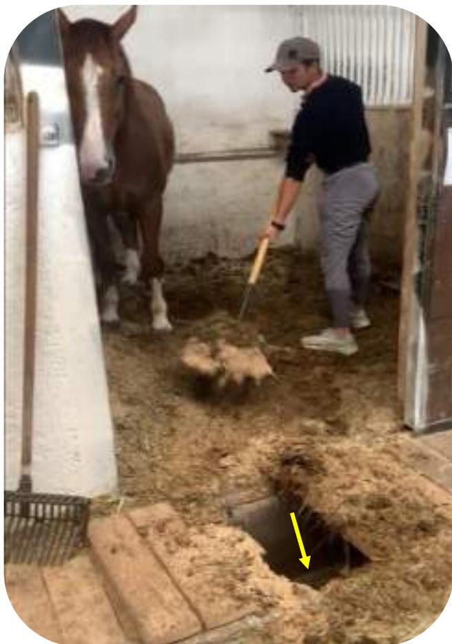
Un caniveau profond : 0,45 m de large, 0,50 m de profondeur
